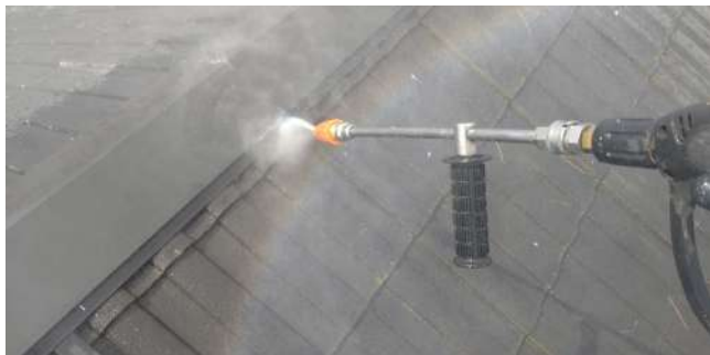
屋根/高压洗净
