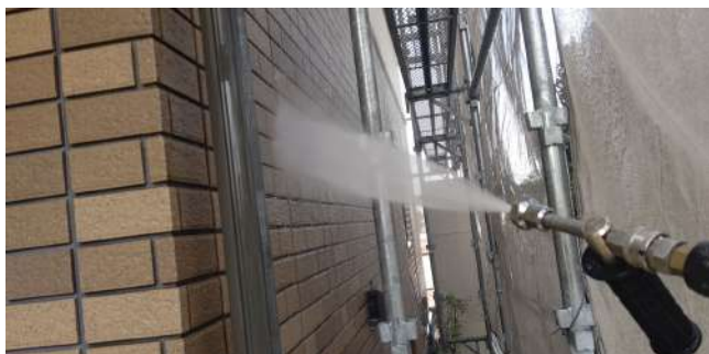
外壁/高压洗净
