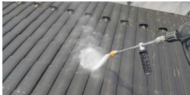
屋根/高压洗净
